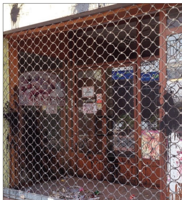
El local abandonado. The abandoned premises.
