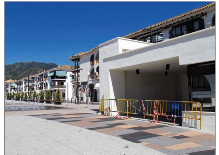
Pueblosol, un parking terminado pero sin uso.
