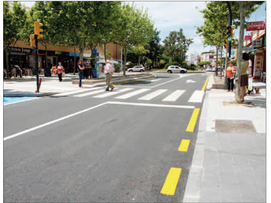
Ya quedaron atrás las antiestéticas vallas de obra.
