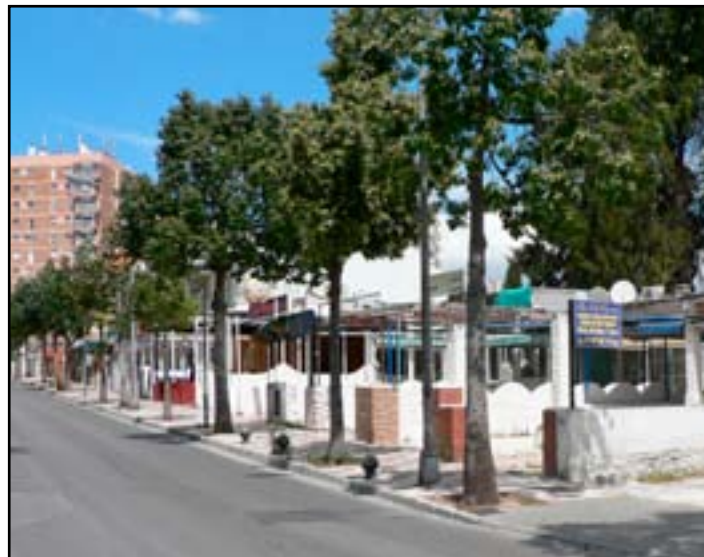
Galerías Maitesa, en evidente estado de deterioro.
