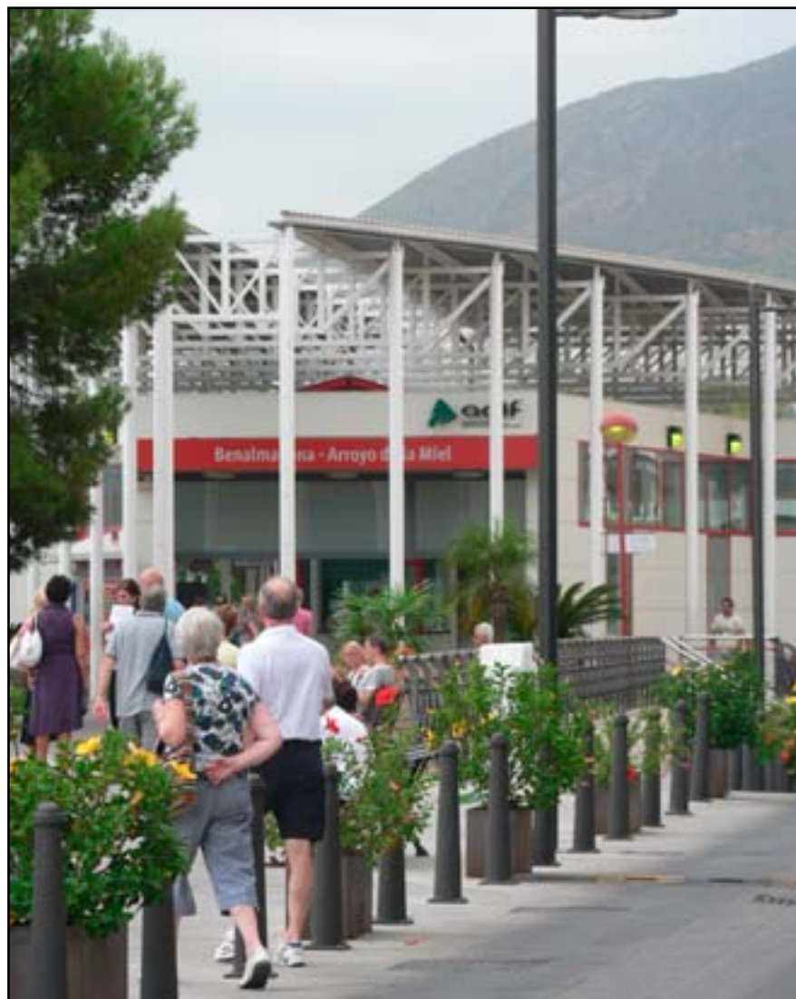
La escalera mecánica de la estación de Cercanías de Renfe en Arroyo de la Miel lleva averiada más de un año, a pesar de ser la línea más usada en toda España.
