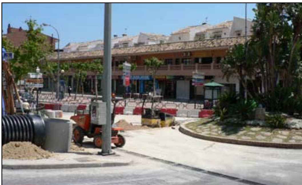
En la rotonda de las avenidas Constitución y García Lorca , las obras suponen el cambio de las canalizaciones de pluviales para prevenir inundaciones, sufragadas por el Plan Estatal y en este caso, con Emabesa .
