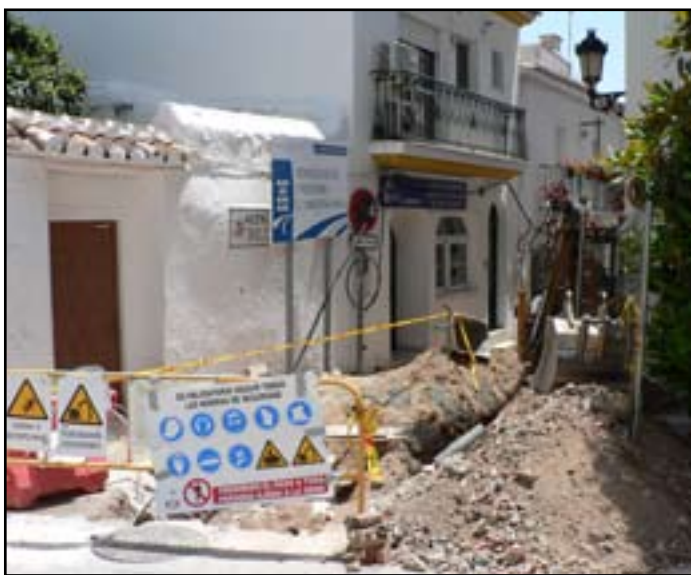
La calle Maestra Ayala , con un plazo de ejecución de tres meses y medio, junto al Ayuntamiento.
