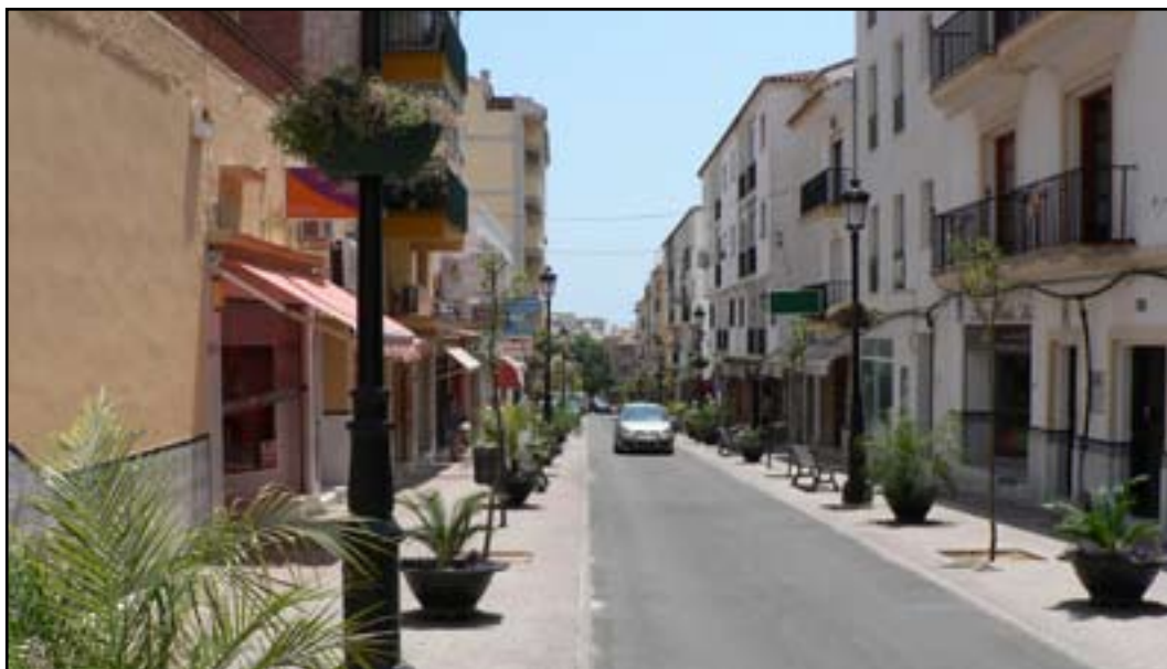
Calle Las Flores después de las obras, finalizadas a mediados de mayo.
