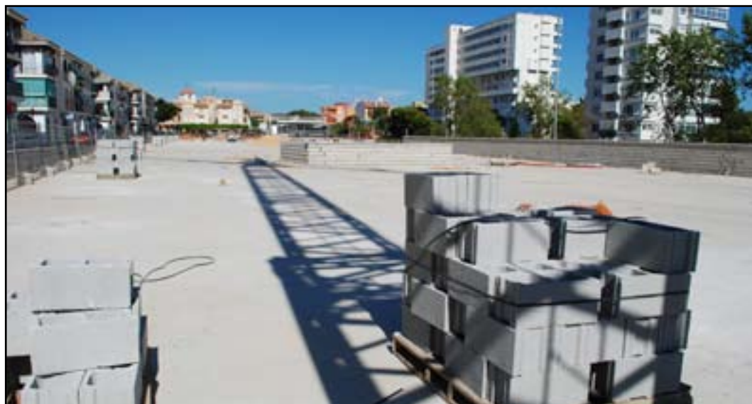
Las obras comenzaron en 2002 y llevan años paralizadas.
