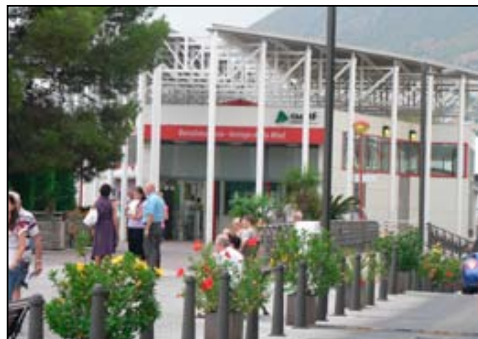
En nombre de los asociados, la ACEB puso una reclamación a ADIF por su dejadez en la reparación de la escalera mecánica de la estación de Cercanías en Arroyo de la Miel. A día de hoy, están en funcionamiento.
