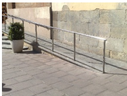
Figura 2. Rampa con barandilla
